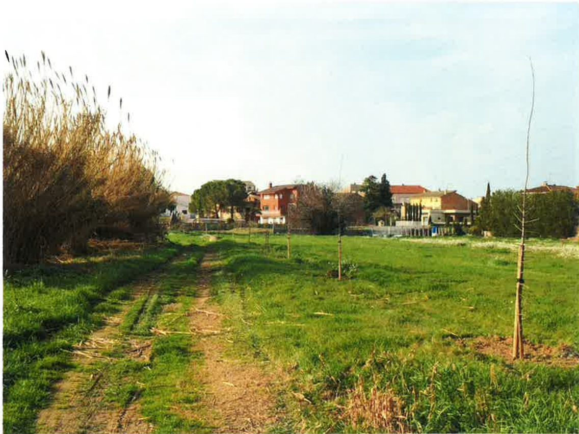
Camí de servei al costat de la finca propietat de l'ajuntament per arranjar en direcció oest. El camí presenta un estat de conservació deficient amb creixement herbaci i entollaments continu
