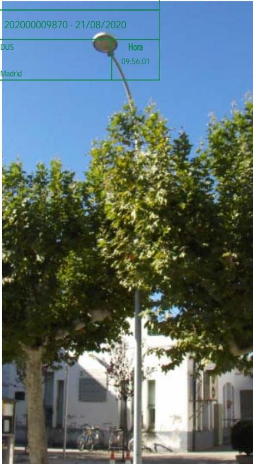
**Fotografía 8.** Recinto de las piscinas municipales. Luminarias tipo globo con lámparas de vapor de sodio de alta presión (VSAP) de 70 W.
