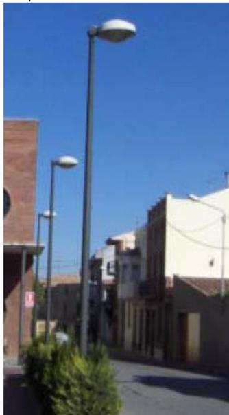
En la memoria inicial se contabilizaron 479 puntos objeto de sustitución. Durante la redacción del proyecto técnico se detecta un total de 489 puntos de luz, con un incremento de 10 puntos de luz de tipo Vapor de Sodio de Alta Presión de 100 W de potencia.
