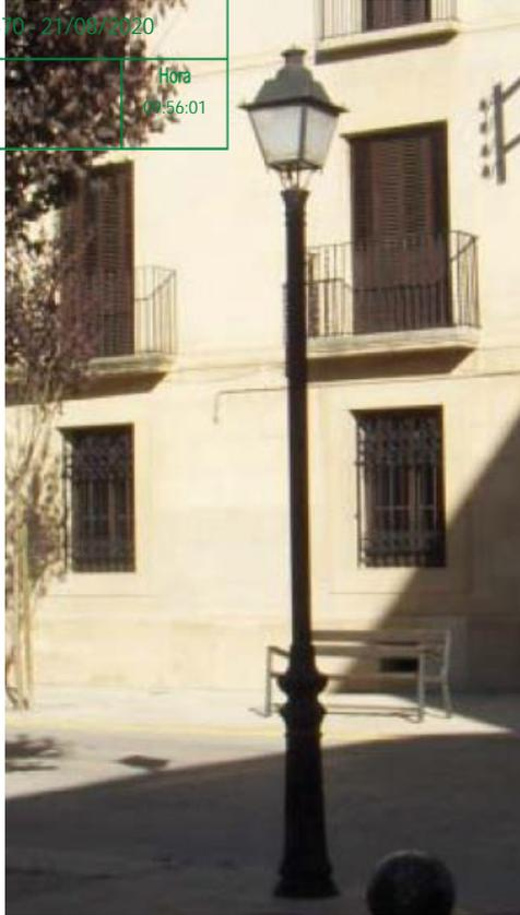
**Fotografía 4.** Plaza del homenaje a la villa. Luminaria de la serie clásica de Carandini con lámparas de vapor de sodio (Vsap) de 150 W.
