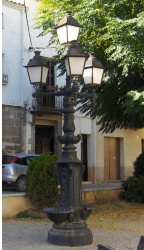
**Fotografía 5.** Plaza del Doctor Segarra. Halogenuro metálico de 400 W enfocando a la fachada de la iglesia.
