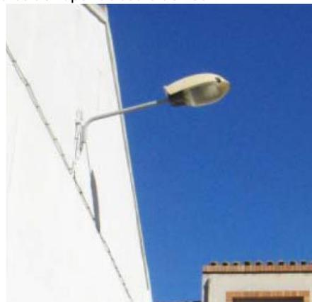
**Fotografía 7.** Paseo de Felip Rodes. Luminarias montadas sobre báculo con lámparas de vapor de sodio de 150 W.
