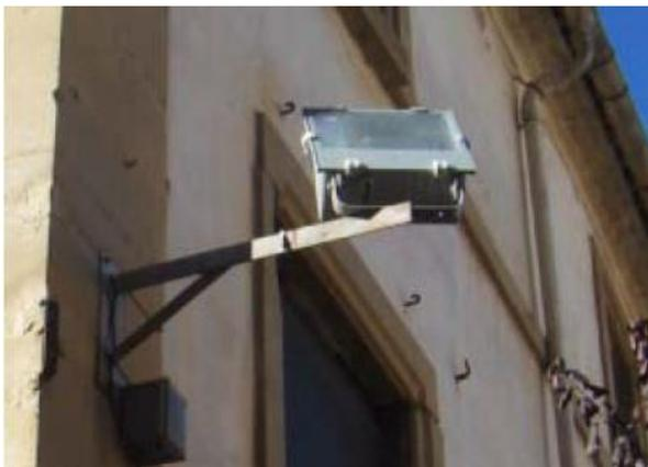
**Fotografía 6.** Esquina de la calle de la iglesia con la calle Sant Andreu. Luminarias montadas sobre brazo con lámparas de vapor de sodio de 100 W.
