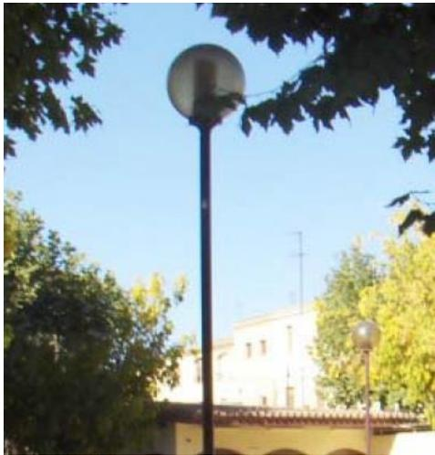
**Fotografía 2.** Calle de Lleida. Luminarias de la marca Carandini montadas sobre brazo con lámparas de vapor de sodio (Vsap) de 100 W. Este tipo de luminarias son las que hay en prácticamente todo el pueblo.
