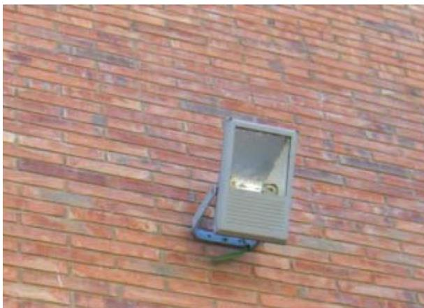
**Fotografía 10.** Avenida del Primer de Maig. Luminaria montada sobre brazo con lámpara de vapor de sodio (Vsap) de 100 W.
